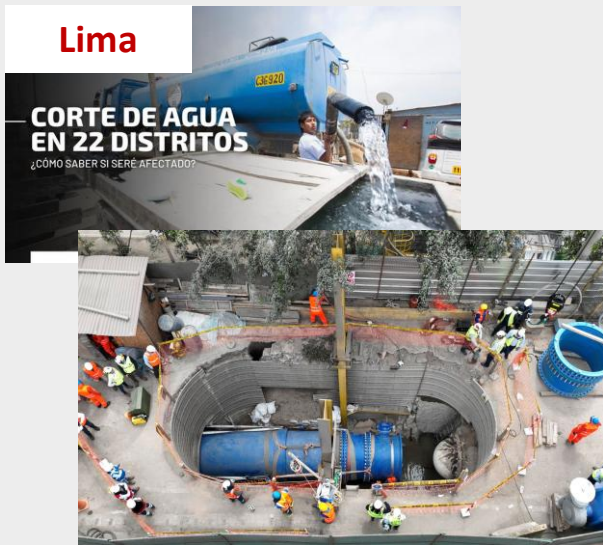
Corte de agua en Lima en 2023 Instalación de tubería Ovni-Ford
