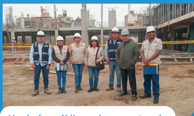
Veeduría pública al proyecto de construcción de la II.EE. Inicial 86. (02/06/2025)
