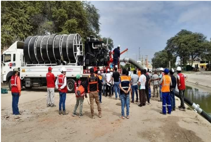
Prueba de funcionamiento del camión trasvasador
